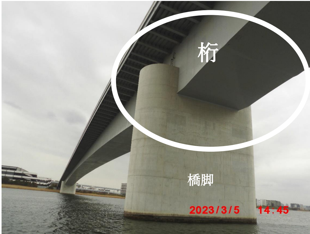
橋脚と橋桁が一体構造になっているラーメン構造でできている橋。 多摩川の流れを阻害しないように少ない橋脚と長いスパン（径間）を確保するための構造。
