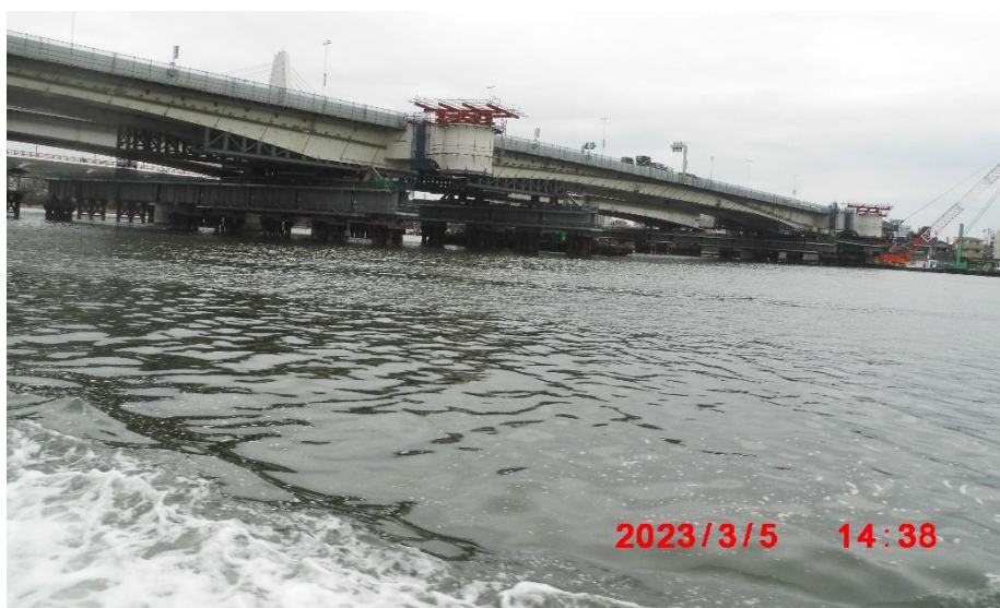
下流側の仮橋と新設の桁。この桁をスライドさせて既存の橋脚の上に乗せる。 5月に工事との事。2週間で工事を終わらせる計画と説明。
