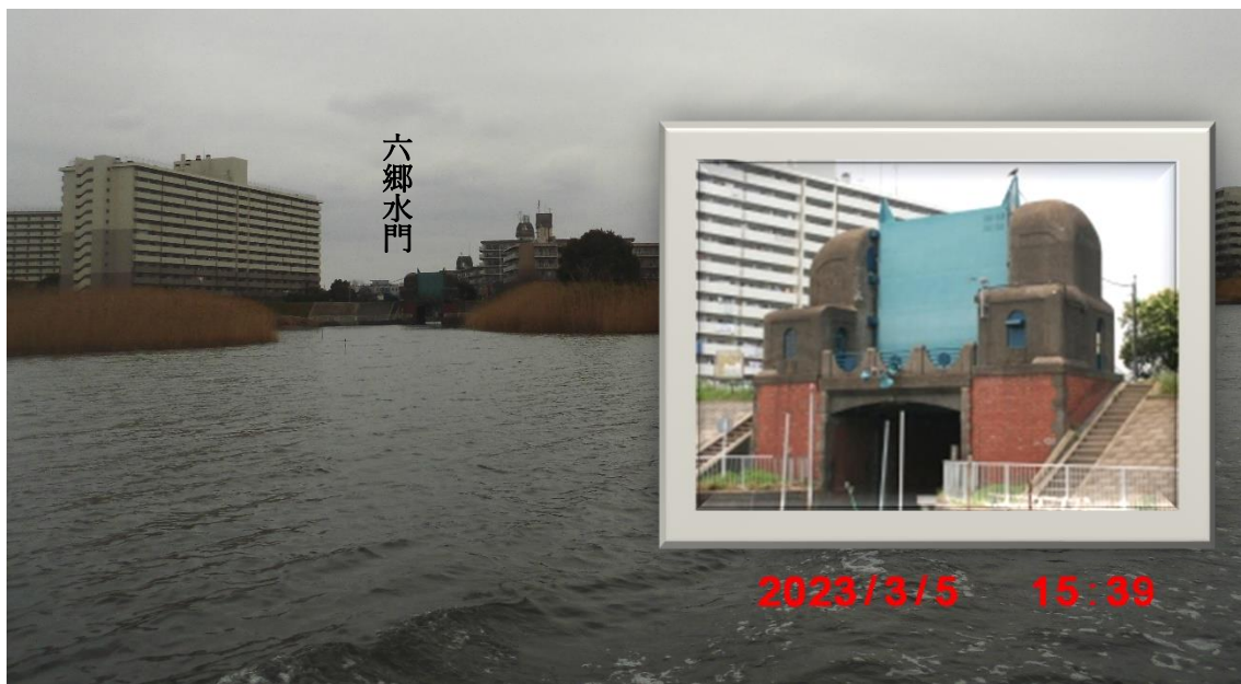
この水門は下水道整備ができるまで生活排水を多摩川に流すために使われたとの事。
