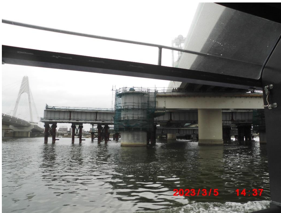
首都高速道路多摩川橋の上流側の仮橋と仮桁 この上に既存の橋桁をずらして乗せて解体
