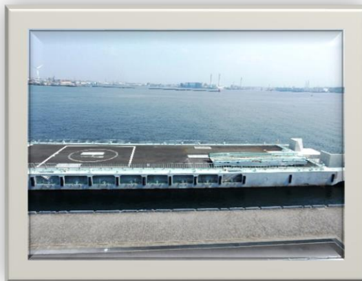
大棧橋客船ターミナル。大棧橋の突端部に浮体式係留施設（ミニフロート）の説明がありました。 災害時の防災拠点としての機能があるそうです。緊急物資、生活用水の確保（ペットボトル）の 保管、海上ヘリポートの役割等。
