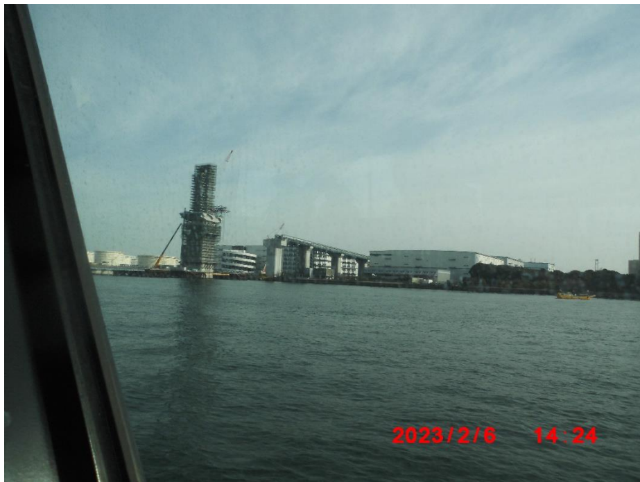
川崎臨港道路の工事中の東扇島側の橋脚
