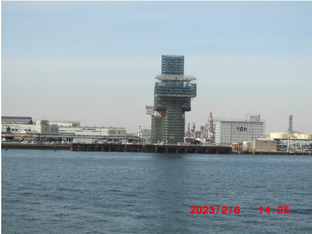
水江町側の橋脚
