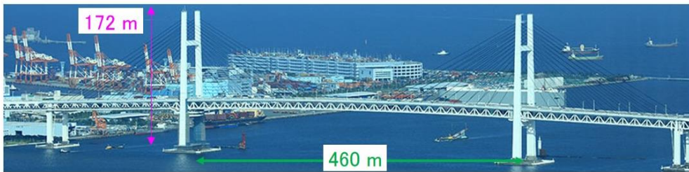
ベイブリッジ 国土交通省京浜港事務所京浜港事務所より参照
