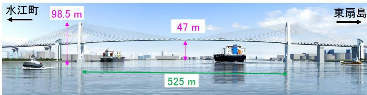
川崎臨港道路橋梁部の完成イメージ 国土交通省京浜港事務所より参照 主塔の高さは羽田空港の空域制限により抑えられている。
