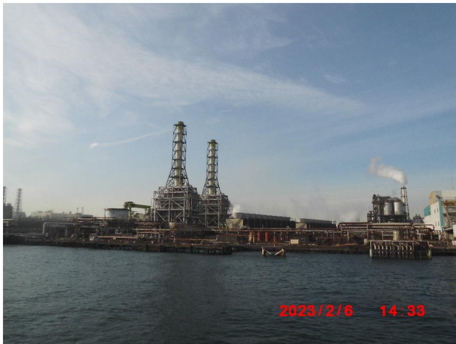
川崎天然ガス発電所。総出力 84.74 万 KW、燃料 LNG コンバインドサイクル発電
