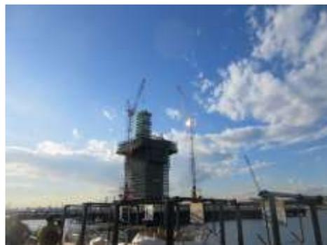
写真 5 MP2 橋脚とその上にクレーンが作業しているのがピロン柱
