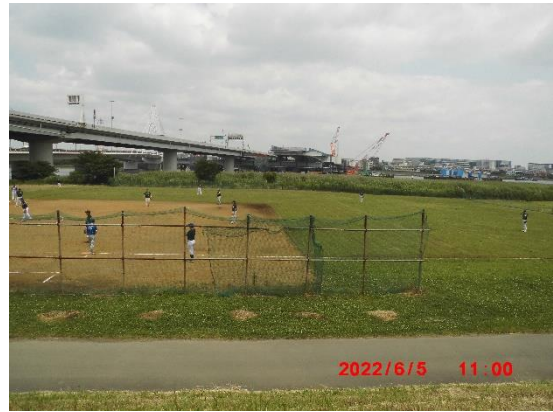
首都高の橋。亀裂が発生してきたため更新工事を行っているとの事。
