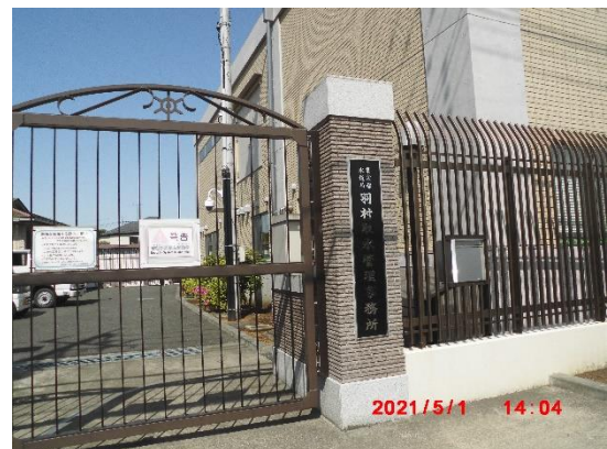
羽村取水管理事務所
