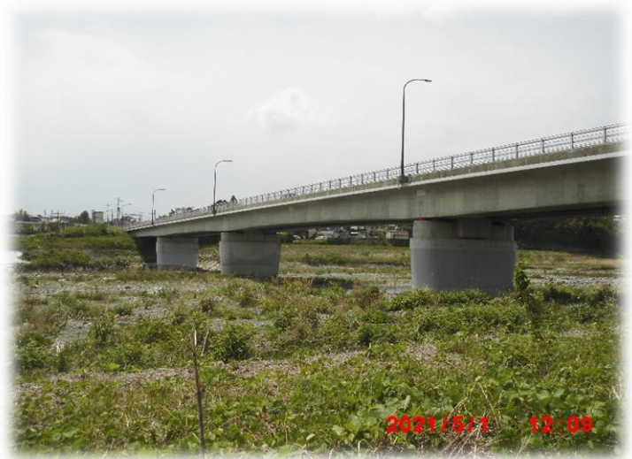
多摩橋。福生市とあきる野市。全長251m。1969年竣工。
