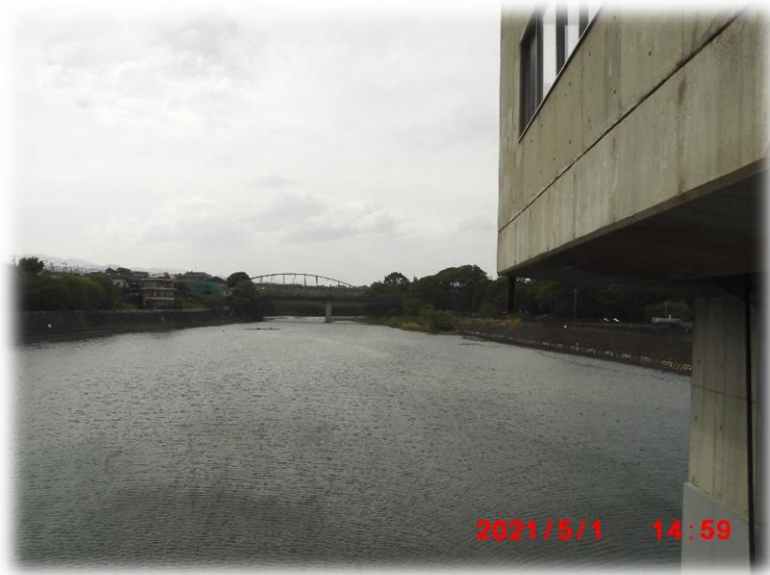
小作取水堰から上流の多摩川橋を望む。
