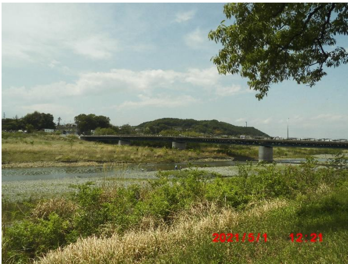
永田橋。全長 241.5m、1973 年竣工。昭和初期には永田の渡しがあったそうです。奥多摩街道と秋川街道を結ぶ道。
