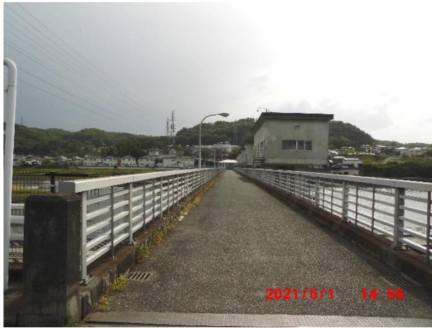
幅員 4m、長さ 193.1m、昭和 55 年 7 月取水堰
