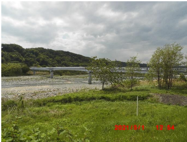
羽村堰下橋。全長 267m。1979 年竣工。 人道橋である。
