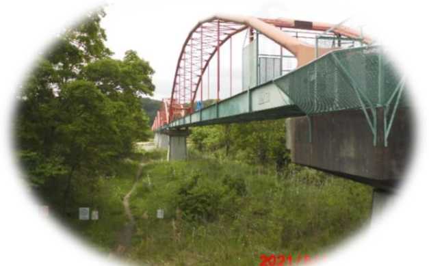
多摩川横断橋と送水管（多摩丘陵幹線）
