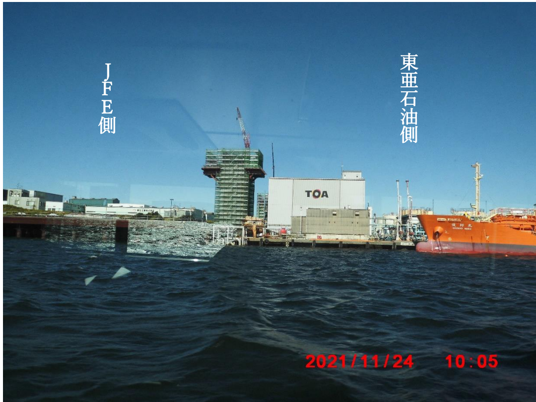
水江町側の臨港道路の橋脚建設中の様子。
