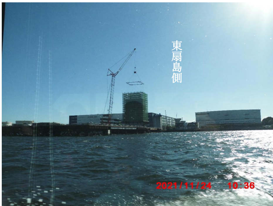
東扇島側の臨港道路の橋脚建設中の様子。
