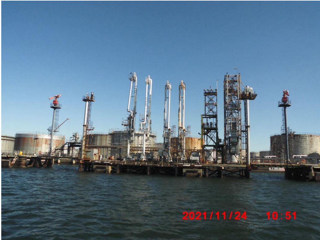
ローディングアーム…タンカーから LNG（液化天然ガス）や LP ガスなどを荷揚げする設備
