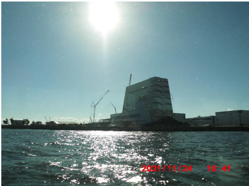
東扇島の東公園と川崎航路トンネルの換気塔
