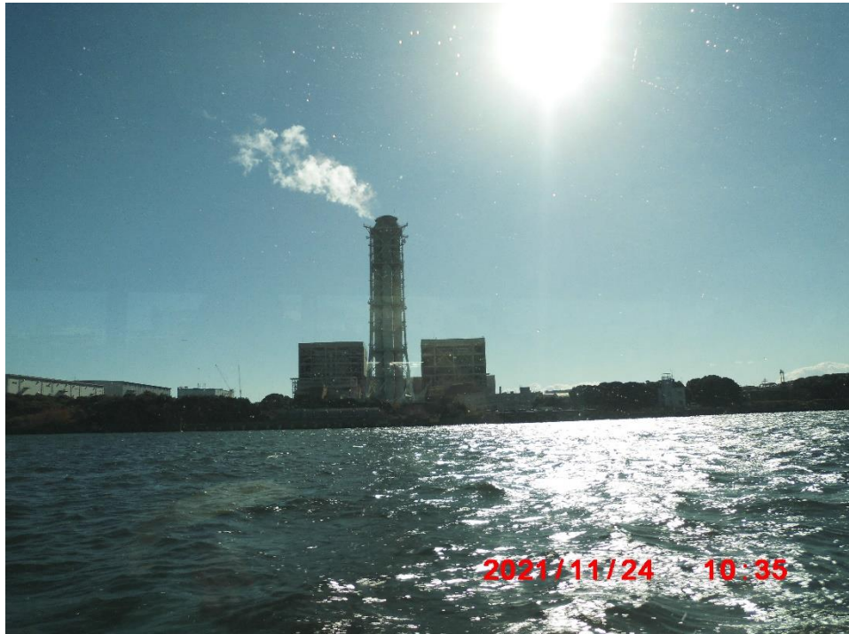
東扇島火力発電所
