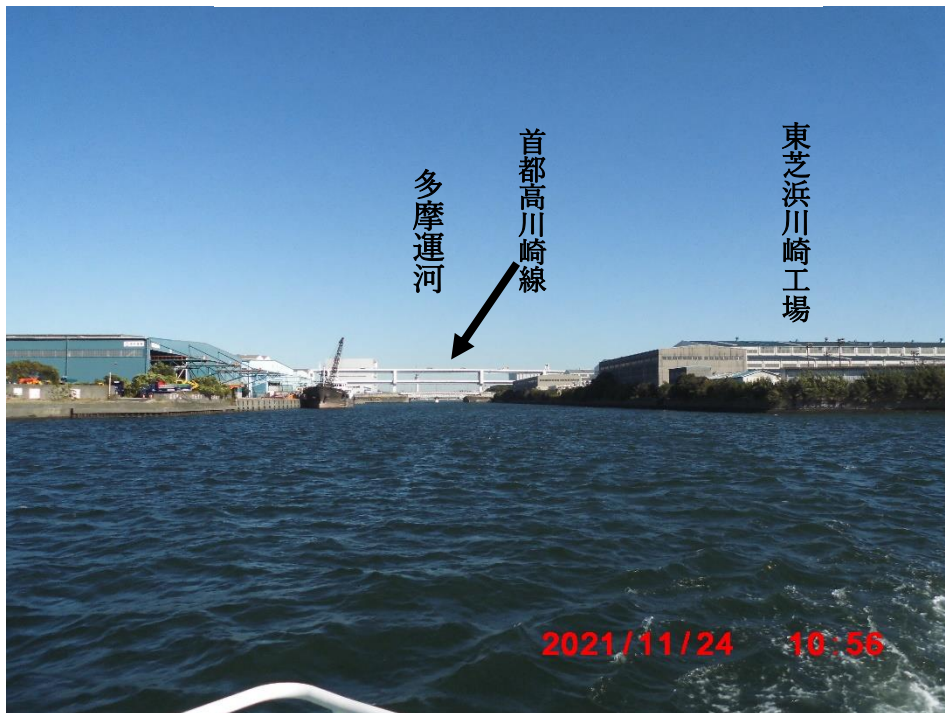
多摩運河の向こうは多摩川。運河は多摩川から流れてくる土砂の影響で浅くなり、定期的に浚渫するとの事。
