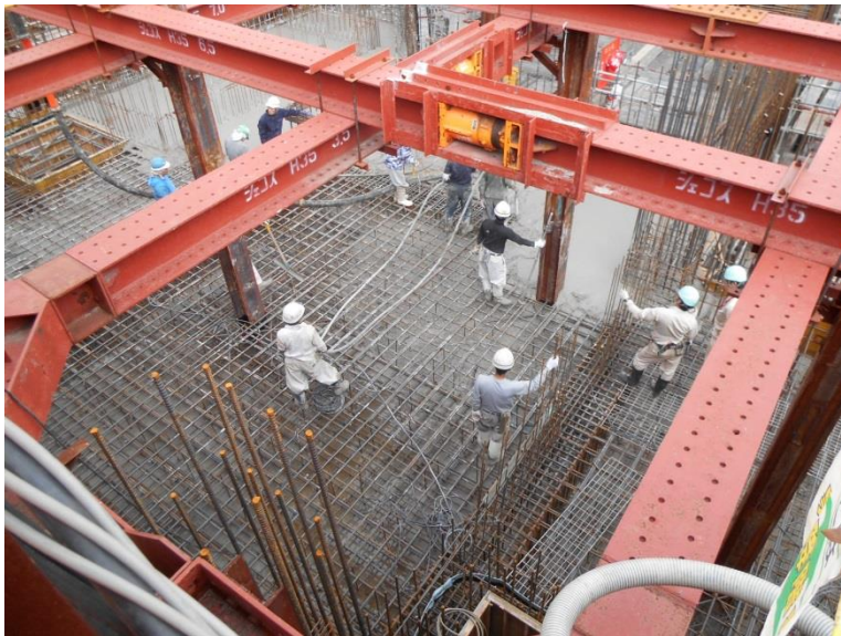
コンクリート打設状況。
