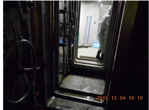
二重扉の前で説明を聞く見学者の皆さん。潜水艦のような扉だと説明がありました。ドライエリアとウェットエリアの仕切り壁は3mの厚さがあるという。
