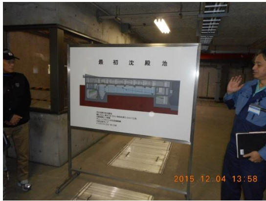
最初沈殿池のパネルの前で説明を聞く。
