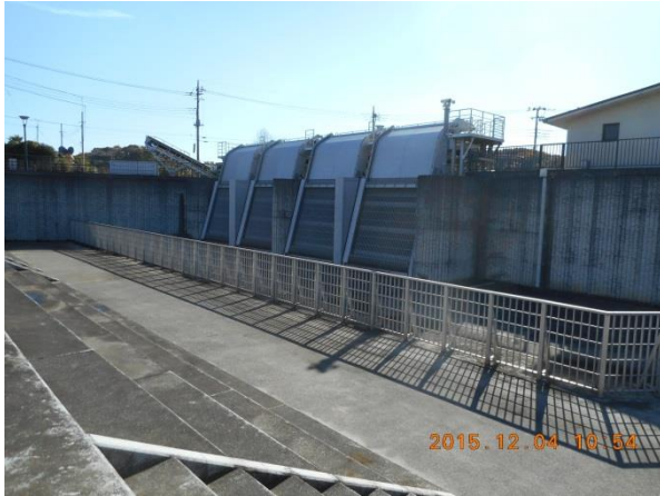
流入路。流木やおおきなゴミを取り除くスクリーン施設。
