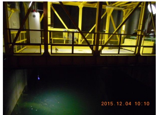
車両用リフトとウォータークッション。底板部に水が張ってある。
