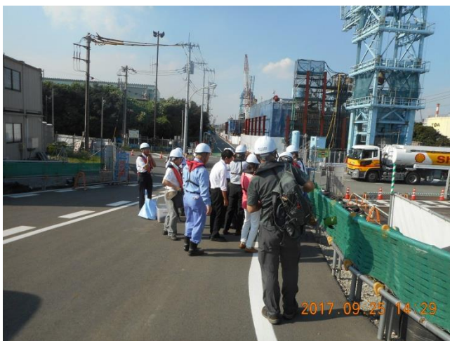
水江町の先端部の建設事務所。 ヘルメット及びライフジャケット着用。
