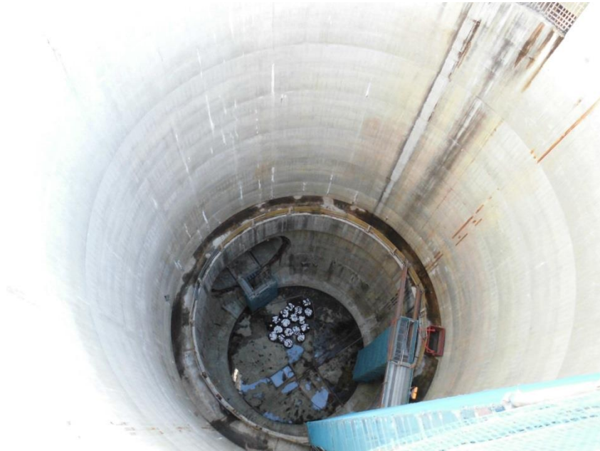
分流部の立坑 21m。この空間は水が流れる部分と施工管理部分などに分割されるそうです。
