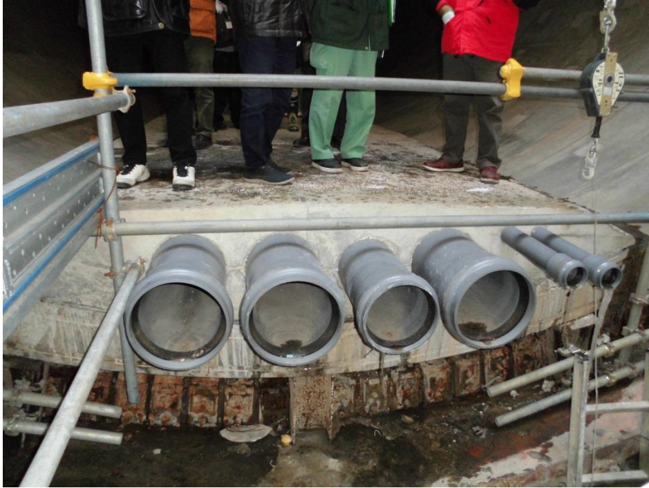
トンネル内に溜まった土砂などを取り除くために水を送るためのパイプだそうです。
