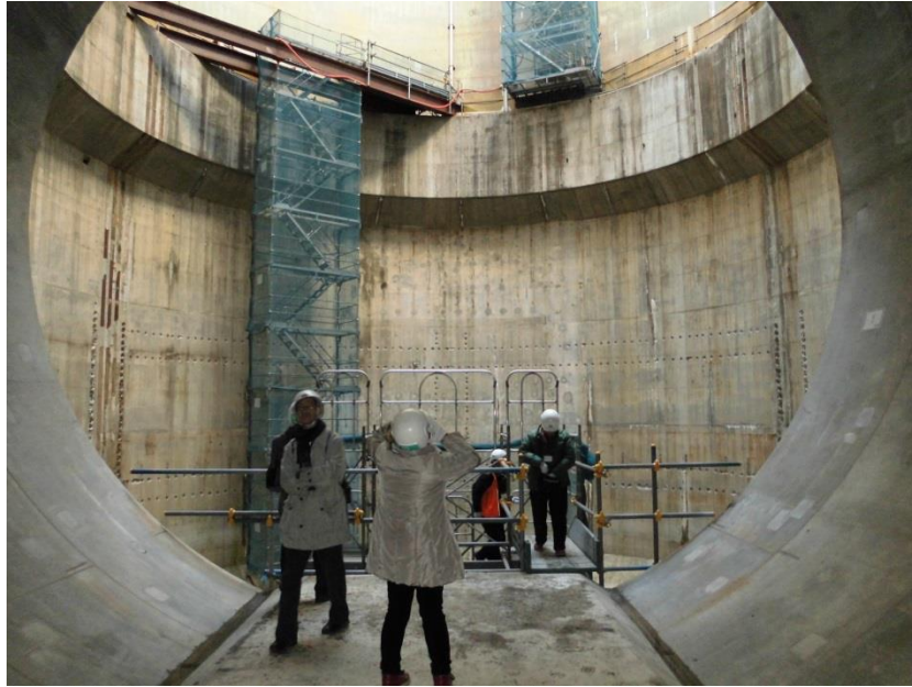
トンネルの大きさに圧倒されました。
