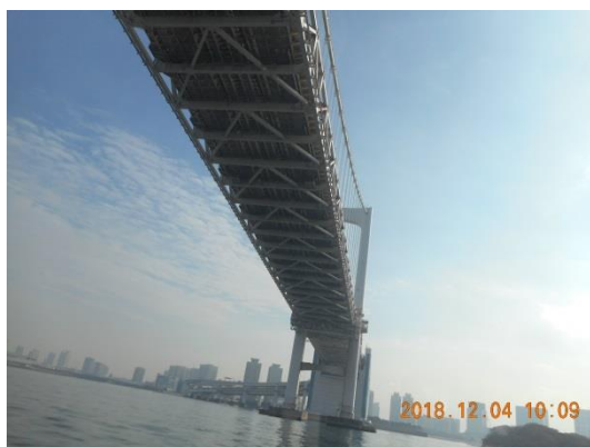
レインボーブリッジ全長 3.75 k m、桁下 52m
