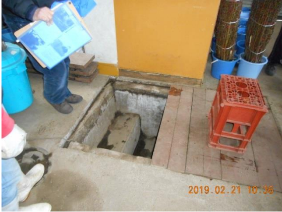
地下のムロの開口部。
