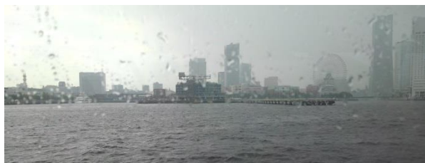
新港ふ頭の客船ターミナル整備中
