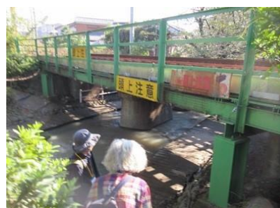
写真6 南武線をくぐります(久地駅-宿河原駅間)
