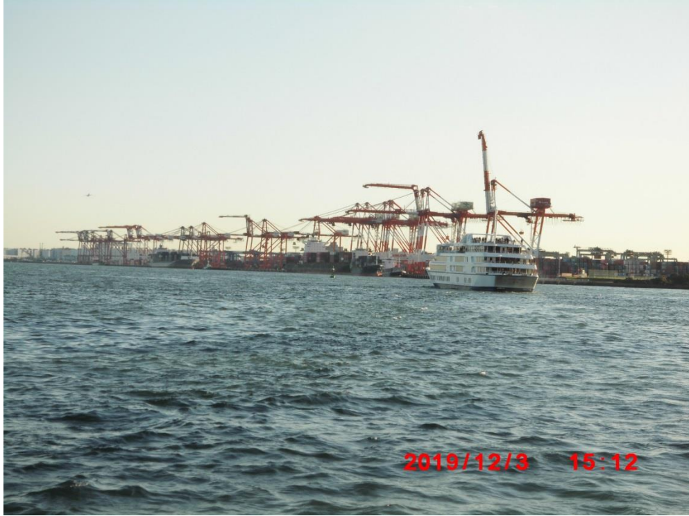
大井コンテナふ頭のガントリークレーン
